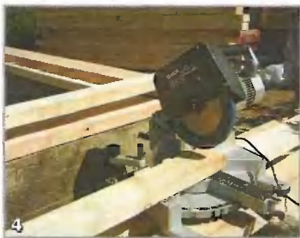
Для изготовления каркасов я использовал доски сечением 100x50 мм. Нарезать их в размер удобно торцовочной пилой
