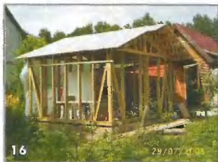
16 Доски обрешетки по кромке свеса обрезал по шнуру
