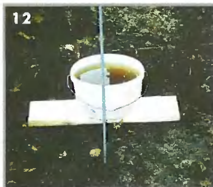
Чтобы спланировать площадку под будущий колодец, в качестве уровня можно использовать обычное ведро с водой
