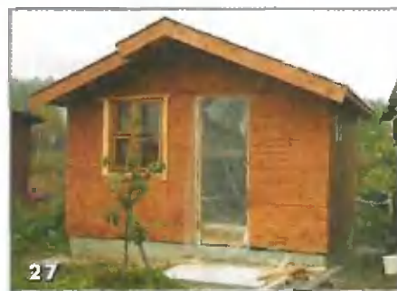
После утепления стен и пола можно приступить к установке окон
