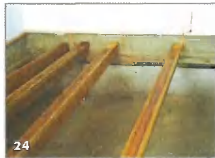
Половые лаги с набитыми черепными брусками. Сейчас они сохнут после обработки антисептиком
