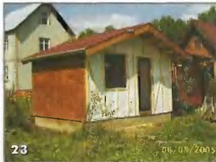
Прежде чем обшивать фронтовую стену, сформировал оконный и дверной проемы
