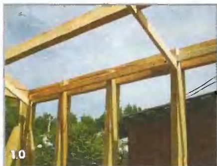
10 Верхняя обвязка — «пятидесятка», установленная на ребро
