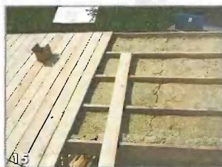
15 Изготовление сплошной обрешетки
