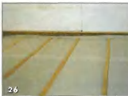
Утепленный пол закрыл пароизоляционной пленкой
