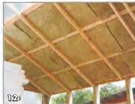
12 В хорошую погоду начал утепление крыши
