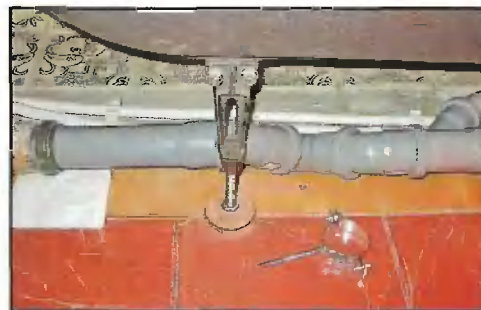
Слив с дополнительным сифоном готов к эксплуатации
