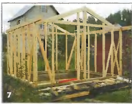
Установлены каркасы всех четырех стен
