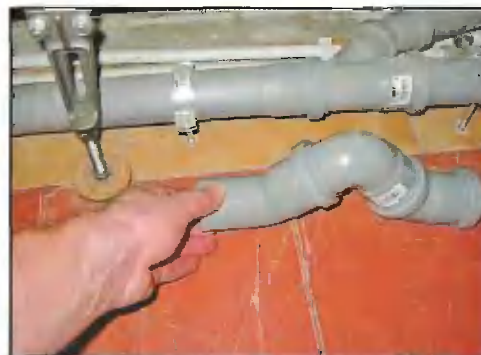
Повернув таким образом сифон при прочистке канализации, можно легко освободить его от скопившегося в нем мусора
