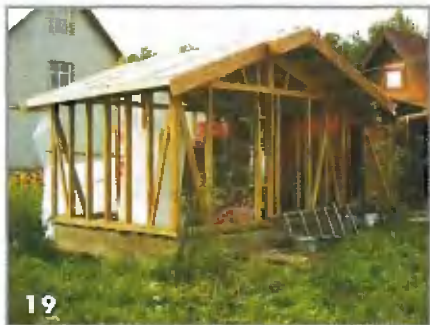
Лобовые доски обработал пинотексом
