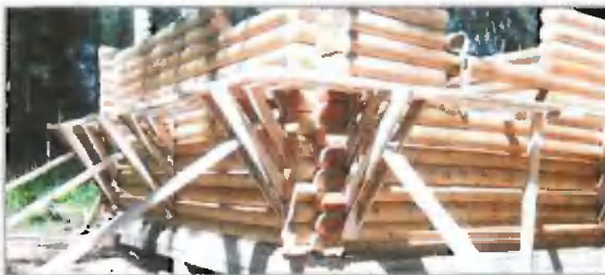
Строительство коттеджа на столбчатых фундаментах с ростверком, приподнятым над грунтом
