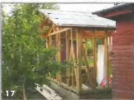
17 Поверх сплошной обрешетки уложил слой рубероида
