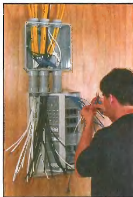
Все провода идут к структурной панели. Провода из всех помещений дома подведены к соединительной коробке — в ней установлены модули, которые распределяют управляющие сигналы по помещениям
