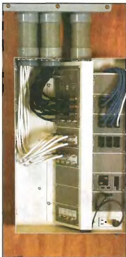
Переключить сеть передачи данных или видеосигнал можно простой перекресткой разъемов
