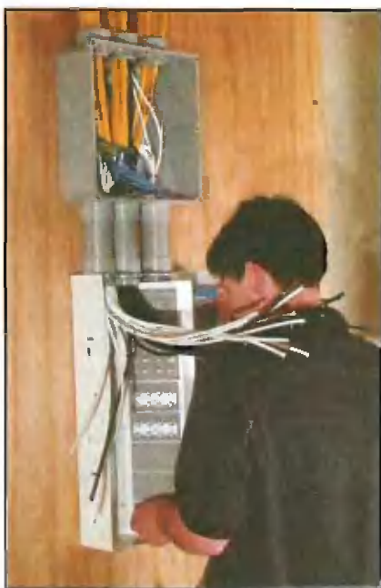
Все провода идут к структурной панели. Провода из всех помещений дома подведены к соединительной коробке — в ней установлены модули, которые распределяют управляющие сигналы по помещениям
