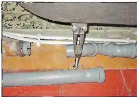
После установки дополнительного сифона трубу необходимо обрезать. Входное отверстие в канализацию обязательно надо закрыть заглушкой
