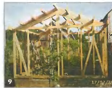
Жестко зафиксировать балки крыши помогают вставки между ними
