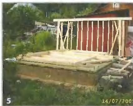
Сборка фронтонной стены. Нижняя обвязка, уложенная на свое место и проверенная по высотам и диагоналям, — это лучший кондуктор для сборки каркасов стен
