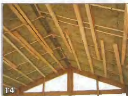
14 Чтобы утеплитель не вываливался, снизу подшил временными рейками
