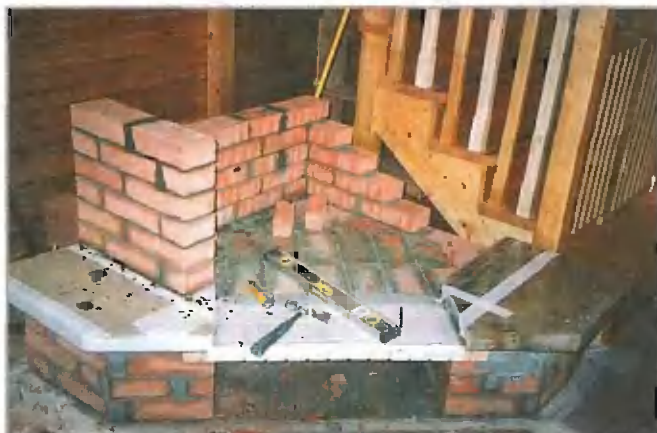
Основание камина выложили, возводим стенку ниши для чугунной топки
