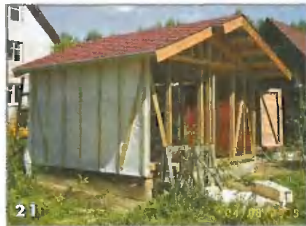
После изготовления крыши приступил к стенам — ветрозащитную паропроницаемую пленку крепил рейками к стойкам
