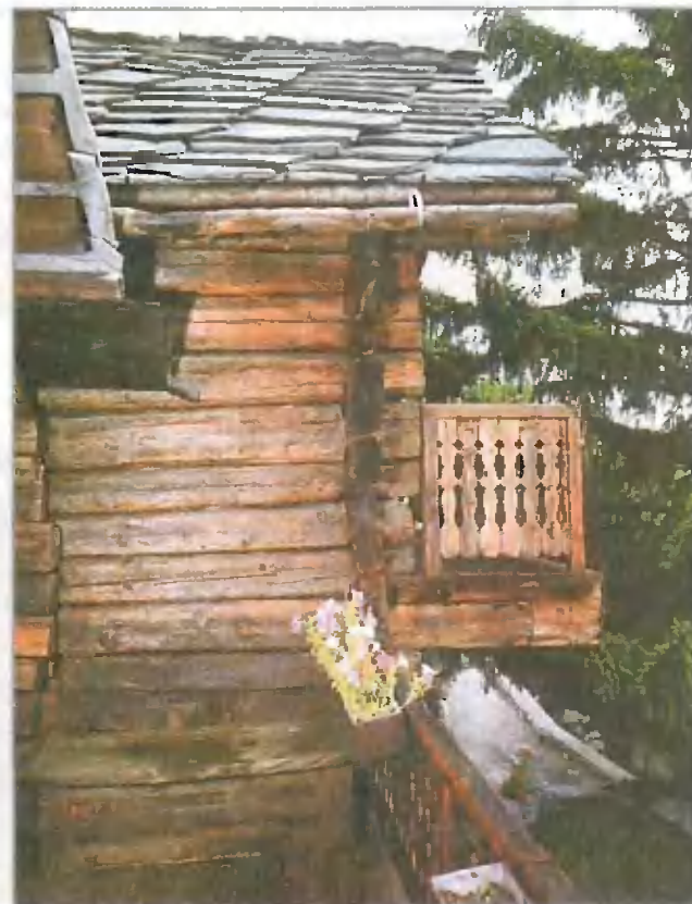
В такого рода сооружениях осадка стен, сложенных из бревен, — примерно 6 см на этаж, с чем архитектору пришлось считаться, прежде чем приступить к размещению различных архитектурных деталей. Здесь над традиционными балконами водостоки выполнены из полых стволов сосны. На балконе на переднем плане — скамья-ларь из лиственницы
