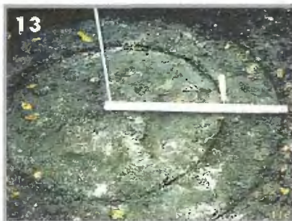
Контуры железобетонного «ножа» можно вычертить с помощью простейшего приспособления, состоящего из прутка, рейки и шила
