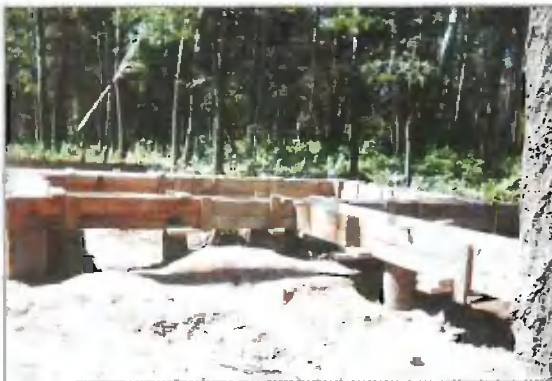
Строительство коттеджа на столбчатых фундаментах с ростверком, приподнятым над грунтом
