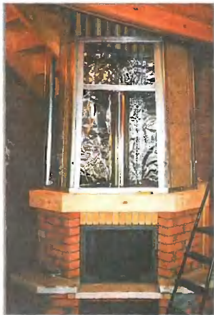
В каркас короба дымохода необхо- димо вставить теплоизоляцию
