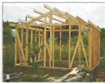
Установка балок крыши. Чтобы обеспечить примыкание скатов, на верхних ребрах конькового бруса сняты фаски
