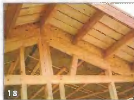
18 Для вентиляции подкровельного пространства в досках-распорках на сверлил ряд отверстий
