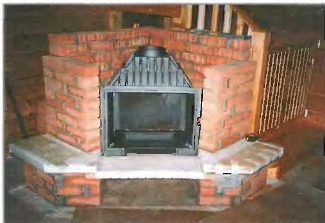
Топку разместили на предназначенное ей место и установили брусья полки
